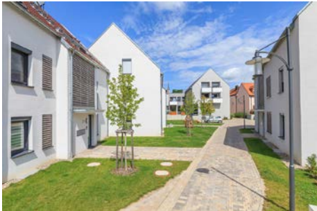
"Die neue Mitte Hettstadts" Tagespflege/Cafe/27 Wohnungen
