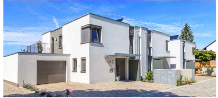
2 Einfam.häuser + 4 Doppelhaushälften "Cubes Seven A-F" Lauf a.d. Pegnitz, 2020
